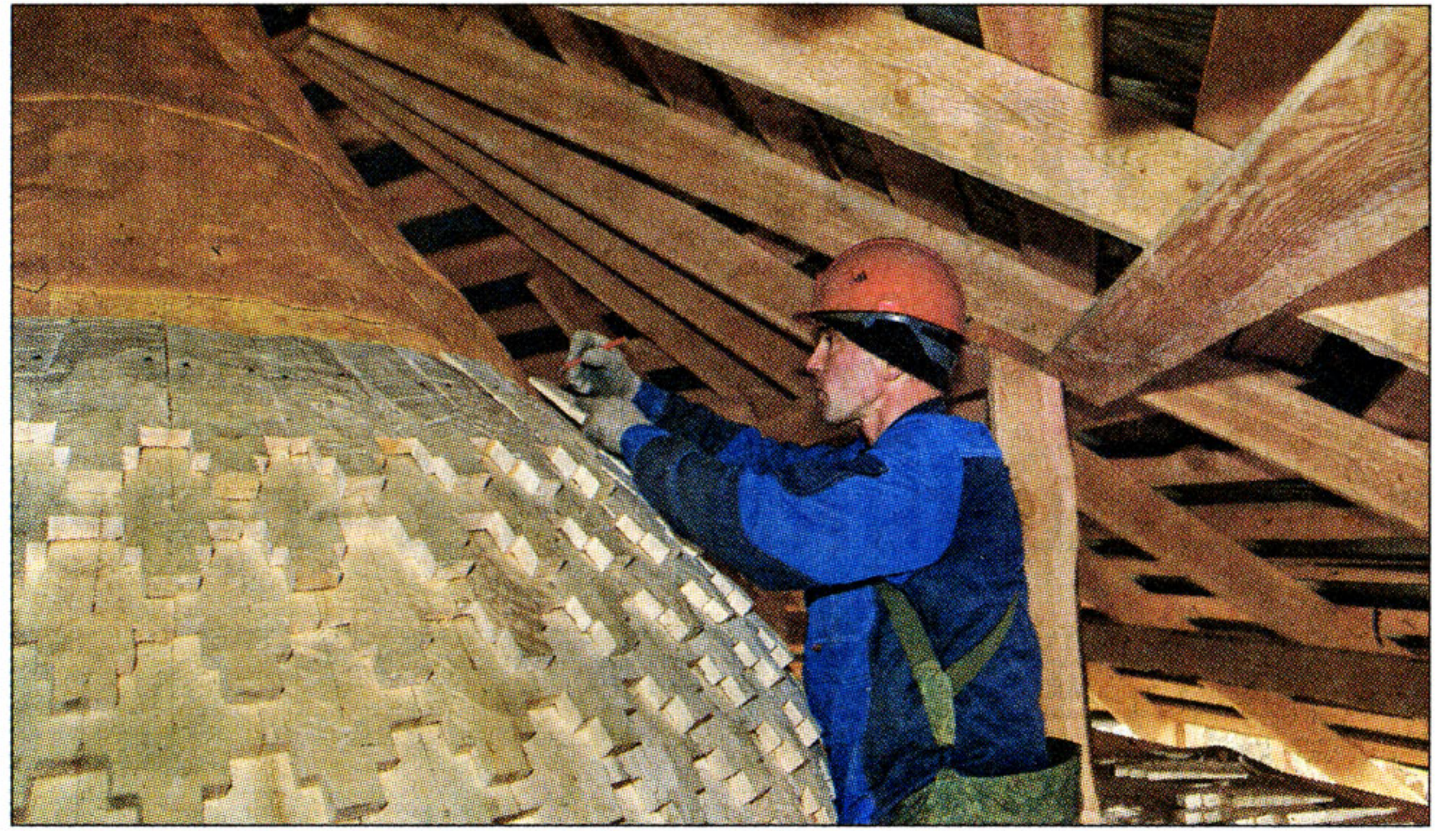
Лемехом (небольшими деревянными пластинами) купола церквей покрывали ещё зодчие Древней Руси
