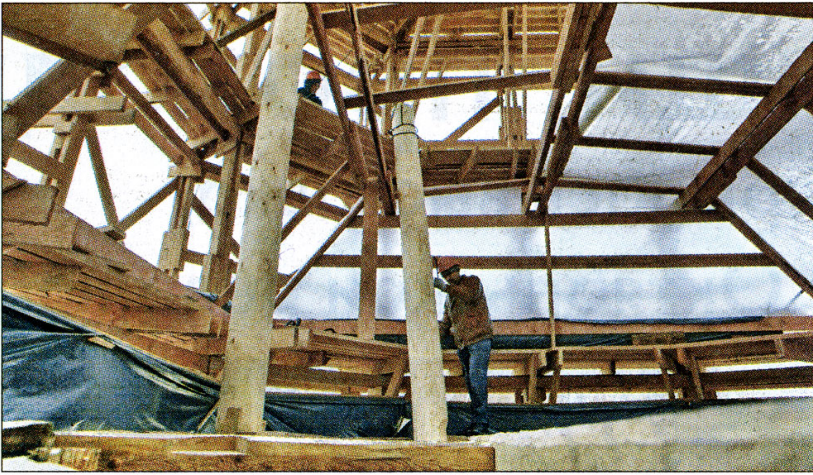
Плотники из Архангельской области — признанные мастера своего дела — устанавливают новые столбы на колокольне
