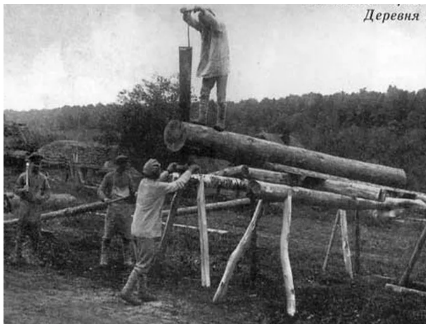
Распилка брёвен на доски.
