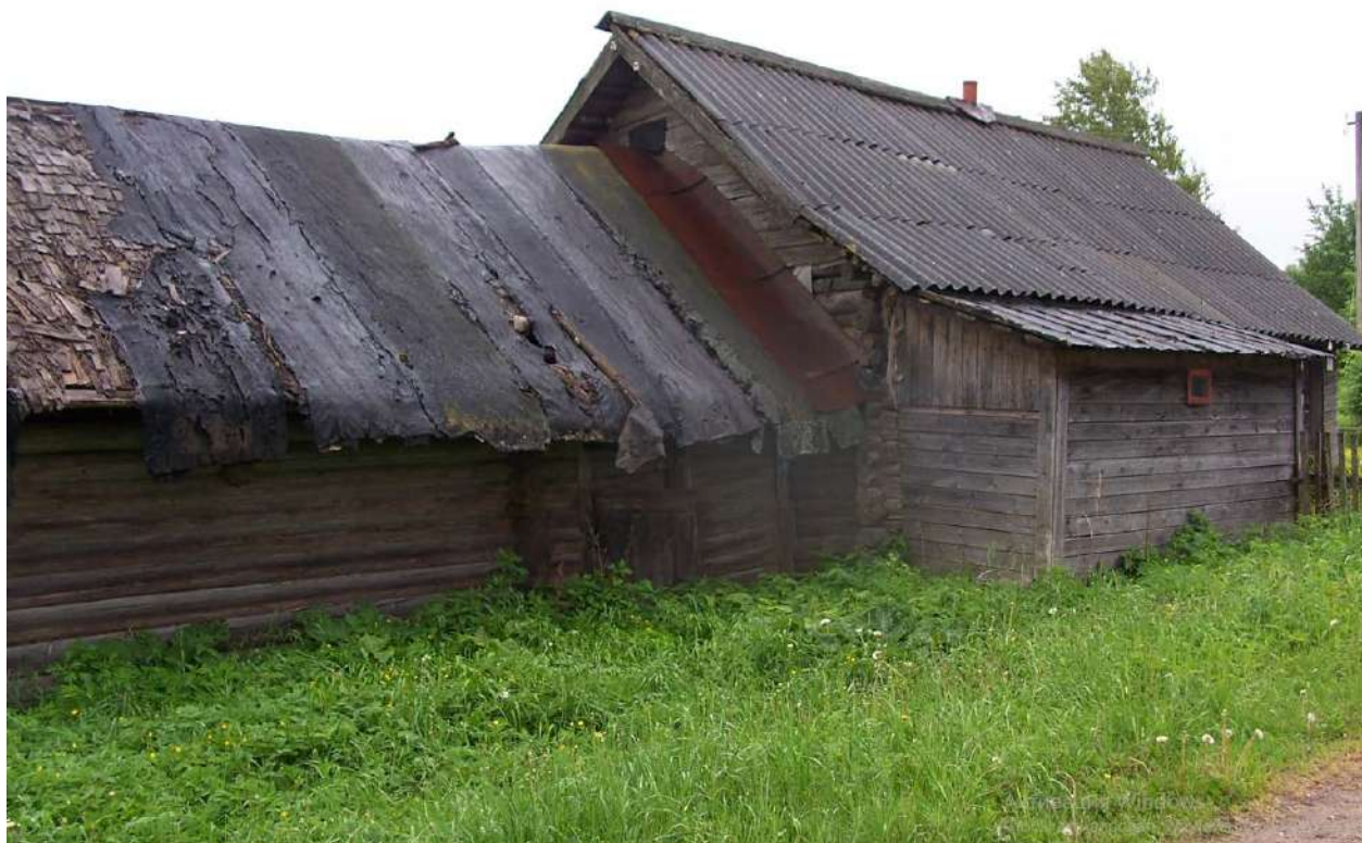
Дом Колесовых . На кровле хлева видно покрытие дранкой.
